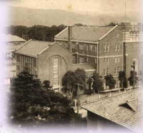
1915～第二代図書館 (現啓明館)
